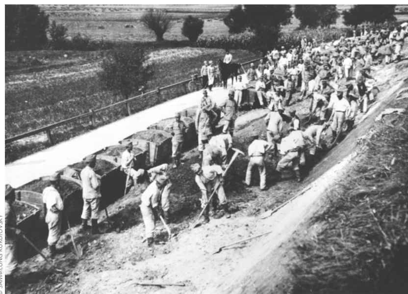
Trassenbau einer „permanenten“ k. u. k. Feldbahn im Raum Korneuburg, Aufnahmezeitpunkt um 1900. Um den Garnisonsort Korneuburg wurden vom Eisenbahnregiment für Übungszwecke eine größere Zahl von Feldbahnstrecken angelegt. Die längste davon hatte eine kreisförmige Streckenführung rund um die Burg Kreuzenstein mit einer Länge von ca. 12 km.
