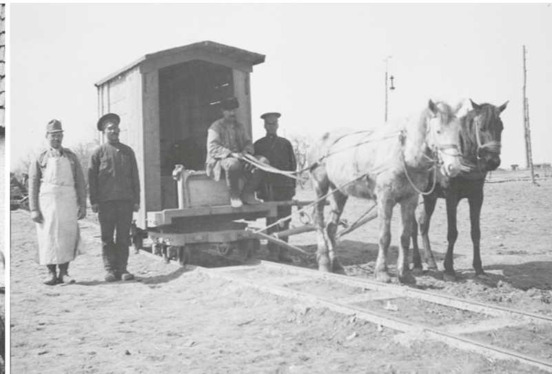
Erster Weltkrieg, Ostfront, Galizien, vierachsiger Feldbahn-Doppelwagen mit selten dokumentierter Pferde-Doppelbespannung. Aufnahmezeitpunkt: 1916/17. Der Fotograf Bruno Reiffenstein (1868-1951) war im Ersten Weltkrieg beim Kriegspressebüro der k. u. k. Armee eingesetzt.
