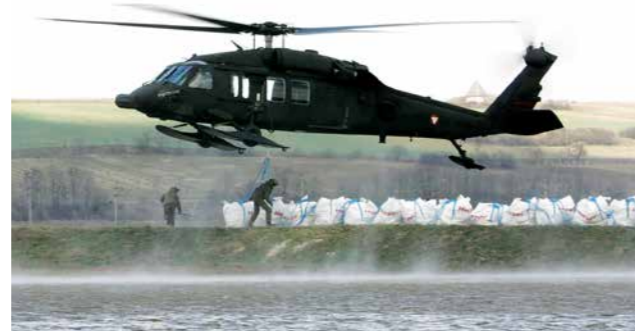
Im Hochwassereinsatz werden hier mit Sandsäcken und Steinen gefüllte Big Bags auf einem Damm Stück für Stück aneinandergereiht.
